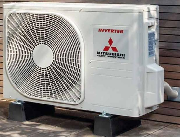
**L**uft-Luft-Wärmepumpen und Komfortklimaanlagen funktionieren als Kombination aus einem Außengerät – und einem oder mehreren Innengeräten. Entscheiden Sie, welche Lösung optisch am besten zu Ihren Anforderungen passt. Wandgeräte sind klein, formschön und lassen sich optimal auf das Umfeld abstimmen. Truhengeräte können flexibel montiert oder einfach aufgestellt werden. Beide Varianten arbeiten sauber und flüsterleise.
